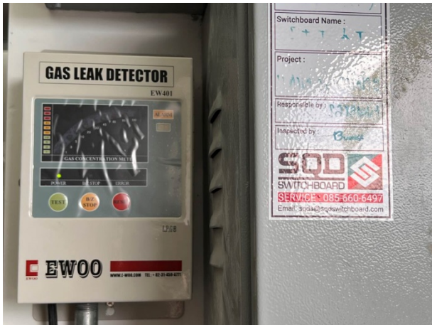
ภาพที่ 2-4 Gas Detector
